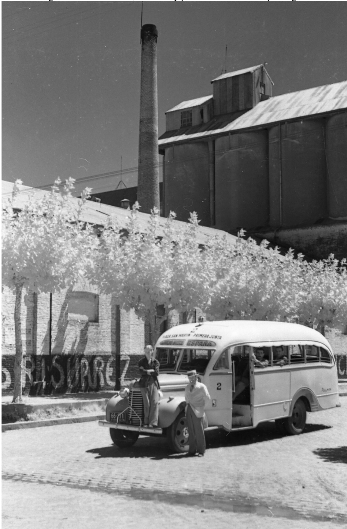
Imagen 5. Vista de los silos, chimenea y parte del edificio de acopio de granos
