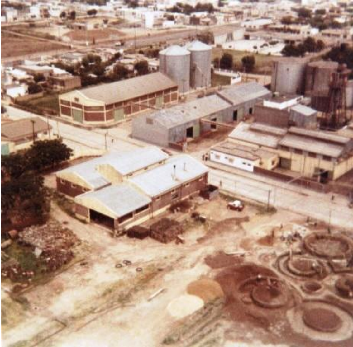
Foto 4: Foto del desguace y desarme de la fábrica. Podemos observar cómo los silos más nuevos habían sido removidos y los galpones de chapa también. Además, se puede divisar cómo la ciudad ya había rodeado a la fábrica.
